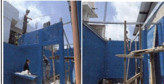
Foto 6: Implementación de lámina troquelada Aluzinc calibre 26 y estructura de soporte de metal para techo.
