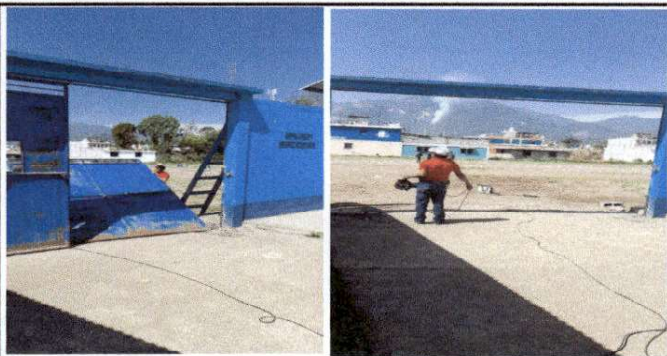
Foto 1: Sustitución de porton principal
