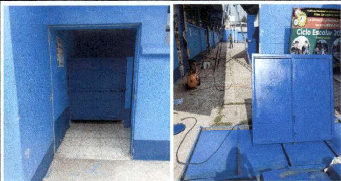
Foto 3: Mantenimiento a estructura, lijado, cambio de tubo, cepillado, sujeciones y aplicación de pintura, puertas de aulas, dirección y servicios sanitarios. (Hombres y mujeres).
