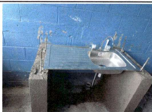
Foto 2: Implementación de lavatrastos (incluye mezcladora)
