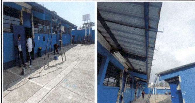
Foto 4: Implementación de canales PVC con soporte o pescantes para canal
