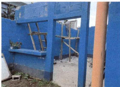
Foto 5: Implementación de ventana y puerta para cocina
